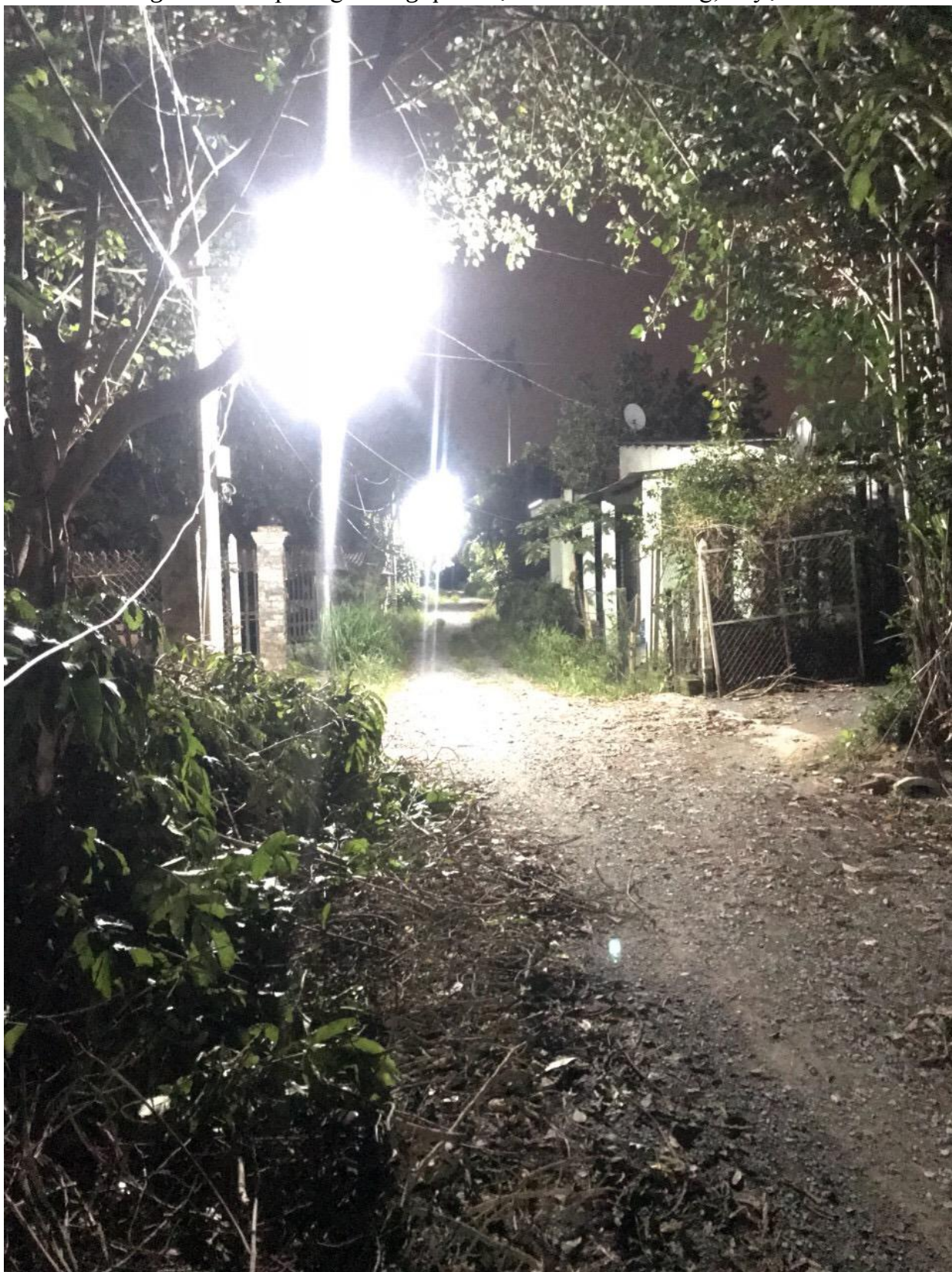
Công trình: Thắp sáng đường quê 2 tại xã Phú Hòa Đông, huyện Củ Chi.
